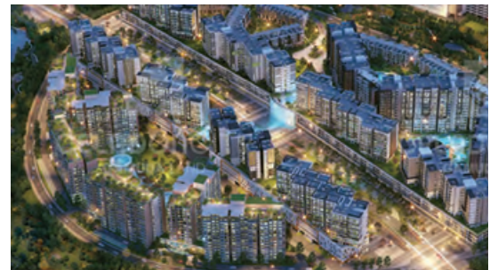
Dự án Chung cư cao cấp Diamond tại Lô A6 Celadon City, Khu đô thị Celadon City, phường Sơn Kỳ, quận Tân Phú
